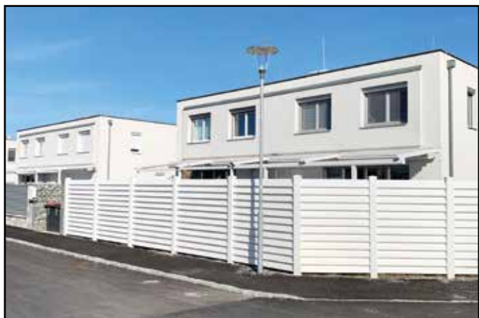
Umrüstung auf LED-Technologie der Straßenbeleuchtung.
