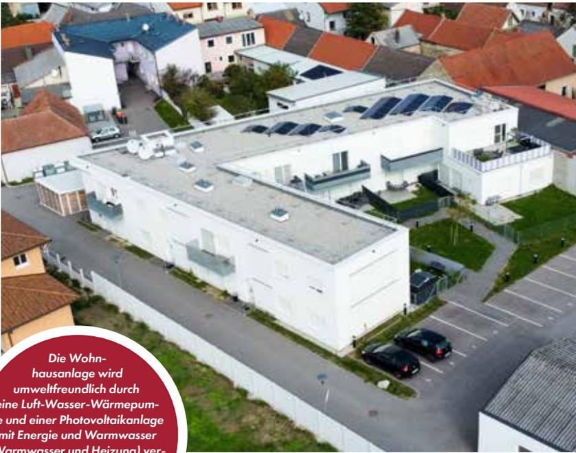
Die Wohnhausanlage wird umweltfreundlich durch eine Luft-Wasser-Wärmepumpe und einer Photovoltaikanlage mit Energie und Warmwasser (Warmwasser und Heizung) versorgt. Es handelt sich bei dem Bau um ein Niedrigenergiehaus mit begrünter Fassade.
